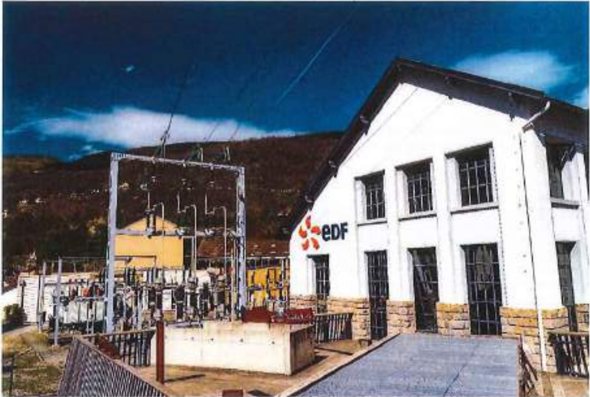
Figure 39 Centrale hydroélectrique du Teich
